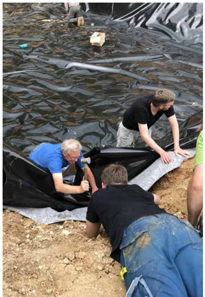
Verlegen der Bodenplane für das Pflanzenklärbeet (oben)
